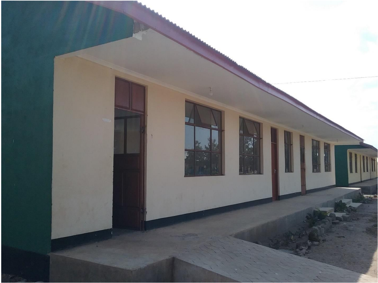
Picha II: Ujenzi wa Madarasa 3 katika Shule ya Sekondari Tingatinga
