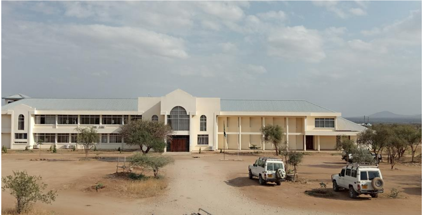
PICHA: Jengo la Utawala la Halmashauri ya Wilaya Longido
